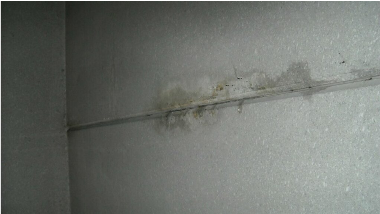
Risse durch Tiefen-Bohrungen
